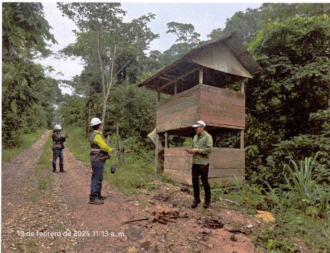
Fotografía N° 01: Vista del Ingreso.
