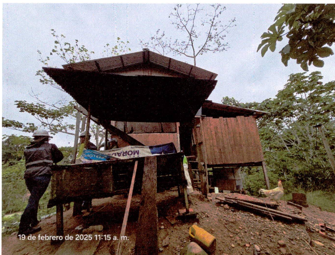
Fotografía N° 02: Viste del área administrativa.
