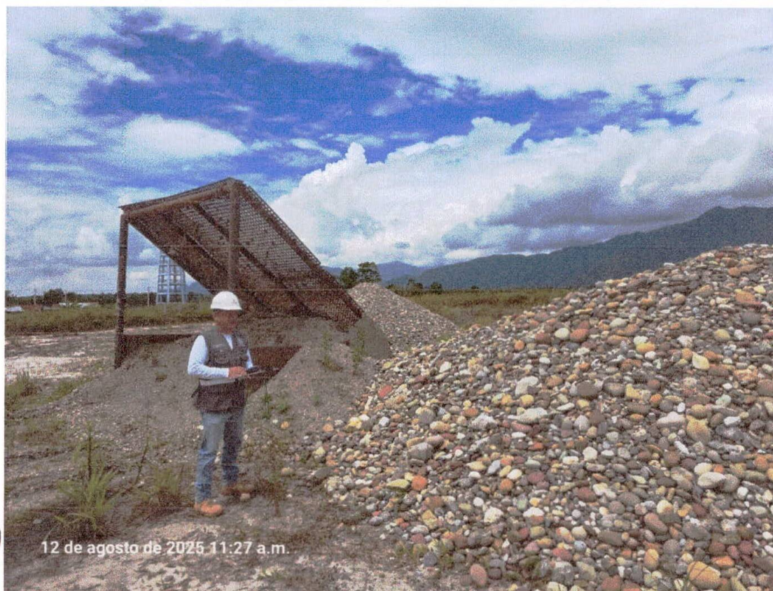
Fotografía N° 5: Vista de material over y zaranda de clasificacion.
