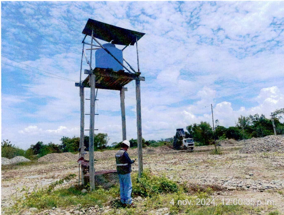
Foto N° 01: Pozo de agua.
