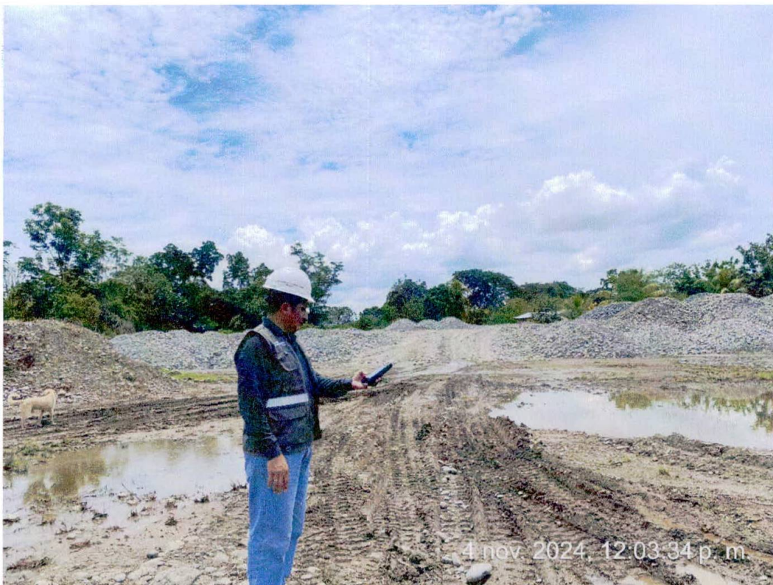
Foto N° 02. Acopio de material.
