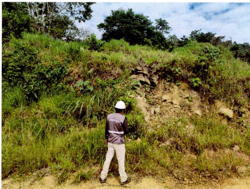
Fotografía N° 04 – Vista de la zona 2.
