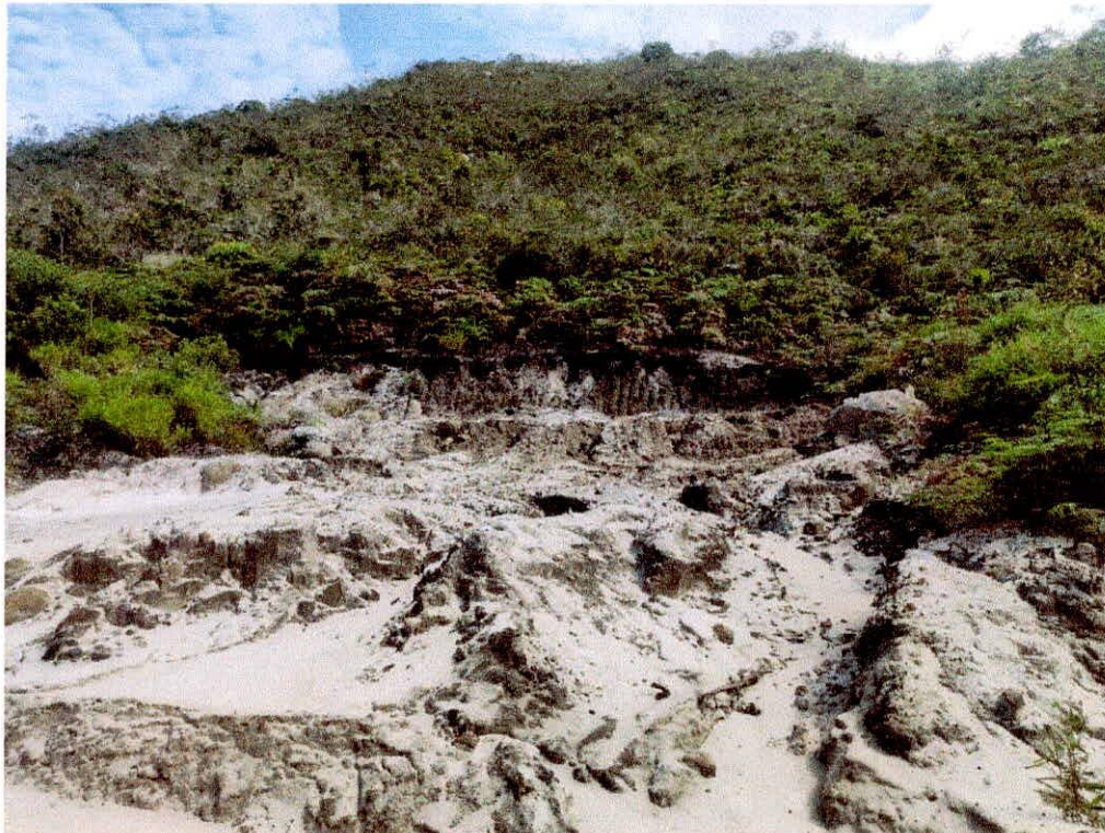
Fotografía N° 4: Vista de área explotación antigua 2.
