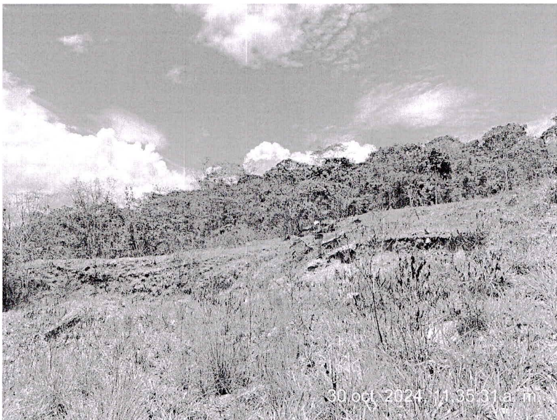
Fotografía N° 2: Vista de la del tajo en revegetación
