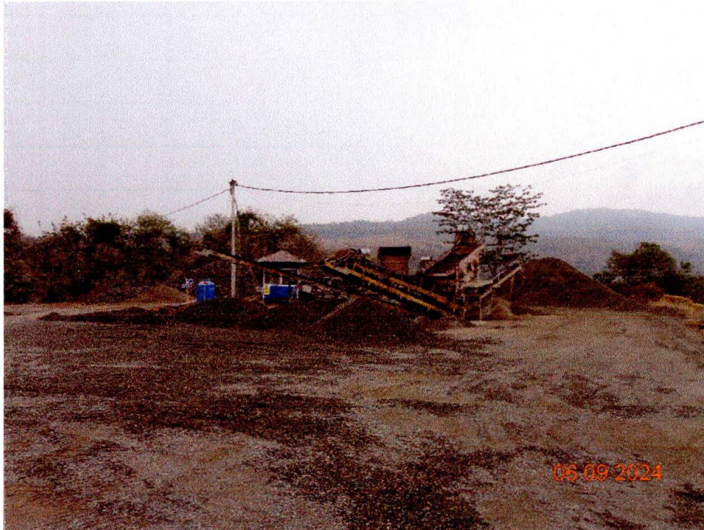
Fotografía N° 1: Vista de la chancadora.
