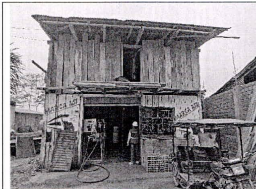
Imagen 2: Vista de la edificación existente
