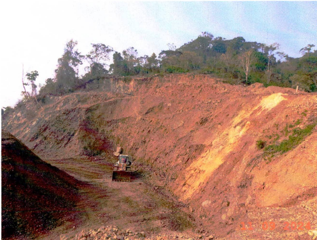
Fotografía N° 4: "Trabajos en el tajo actual"
