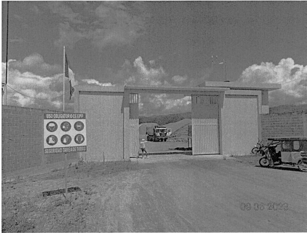
Fotografía N° 1: Vista del ingreso.
