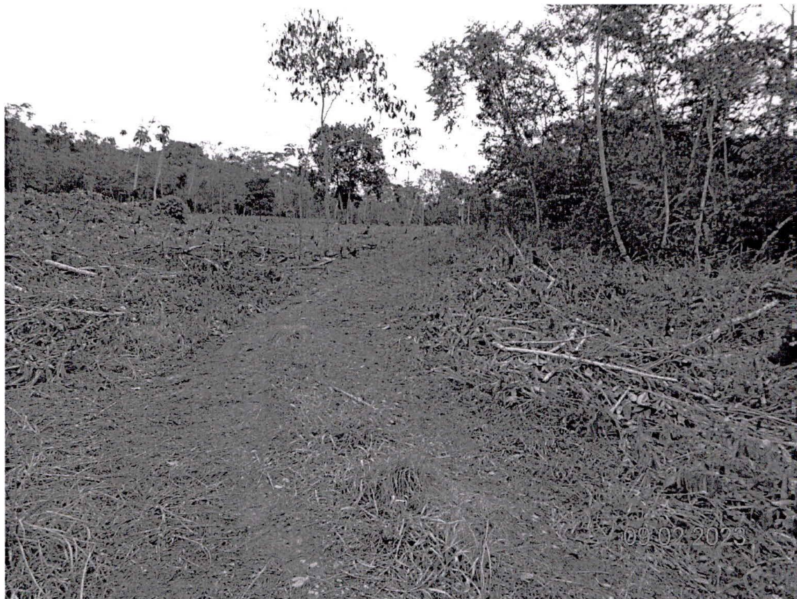
Fotografía N° 4: Vista del acceso.
